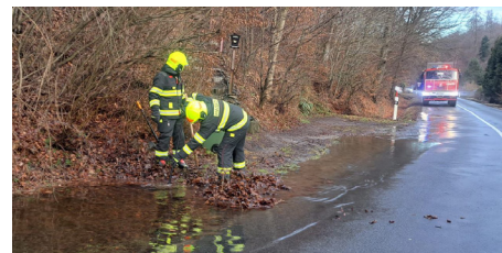
Zatopený propustek přes silnici na Staré pile
